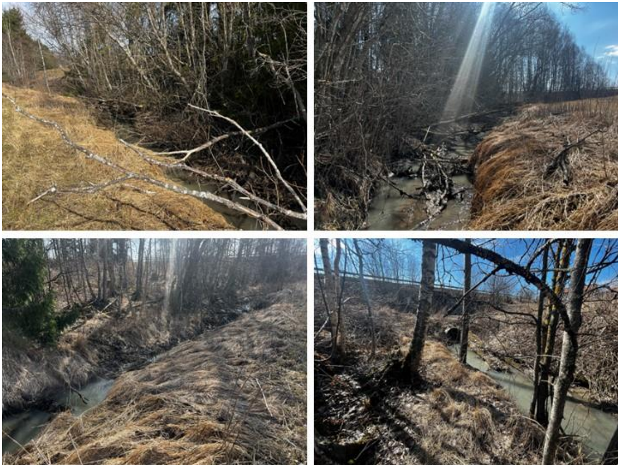
Figur 1-12. Nedre del av bekken som skal erosjonssikres har et bredere belte med tresatt kantvegetasjon på østsiden.
